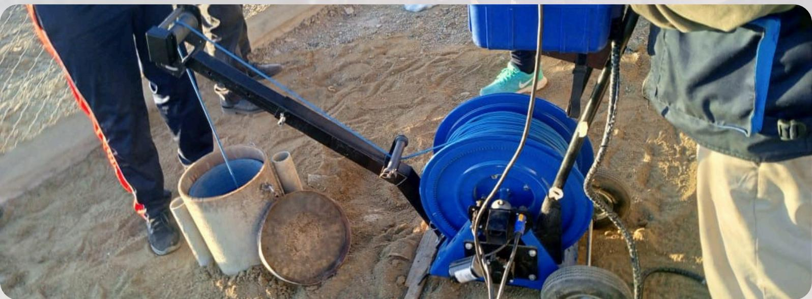
Video inspección: introducción de la video cámara para registro del estado de pozo
