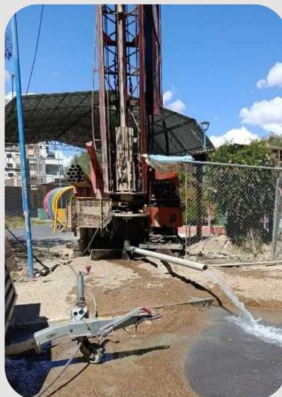
Desarrollo de pozo mediante Air Lift.
