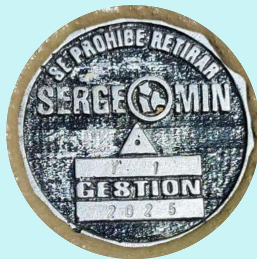
Plaqueta de Aluminio de Punto de Replanteo
