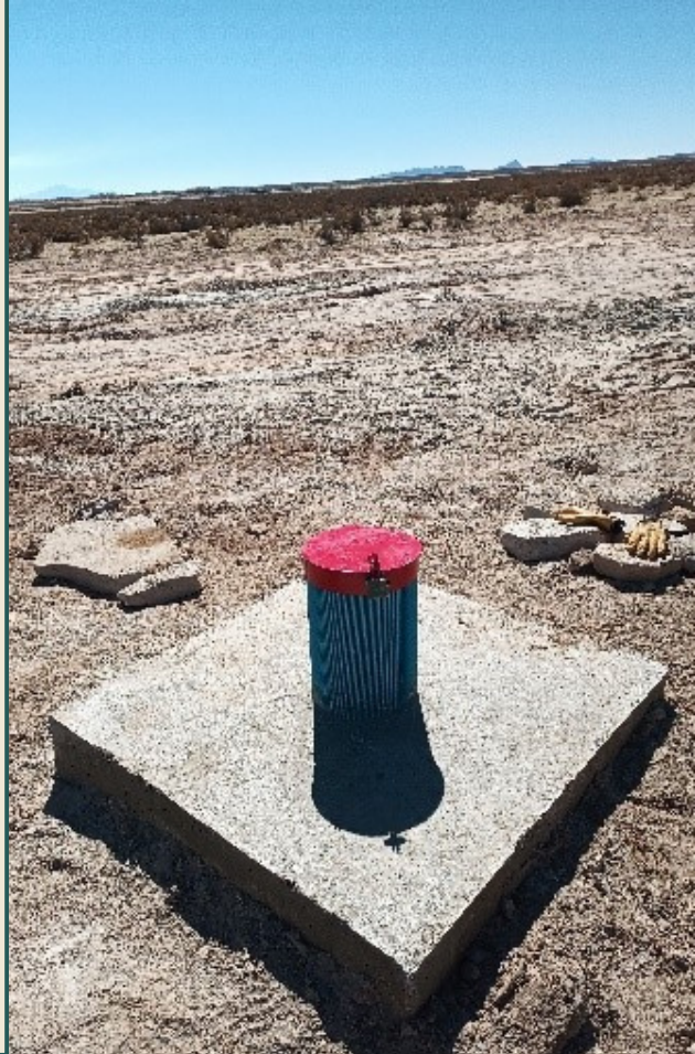
Pozo concluido con su respectiva tapa metálica y sello sanitario
