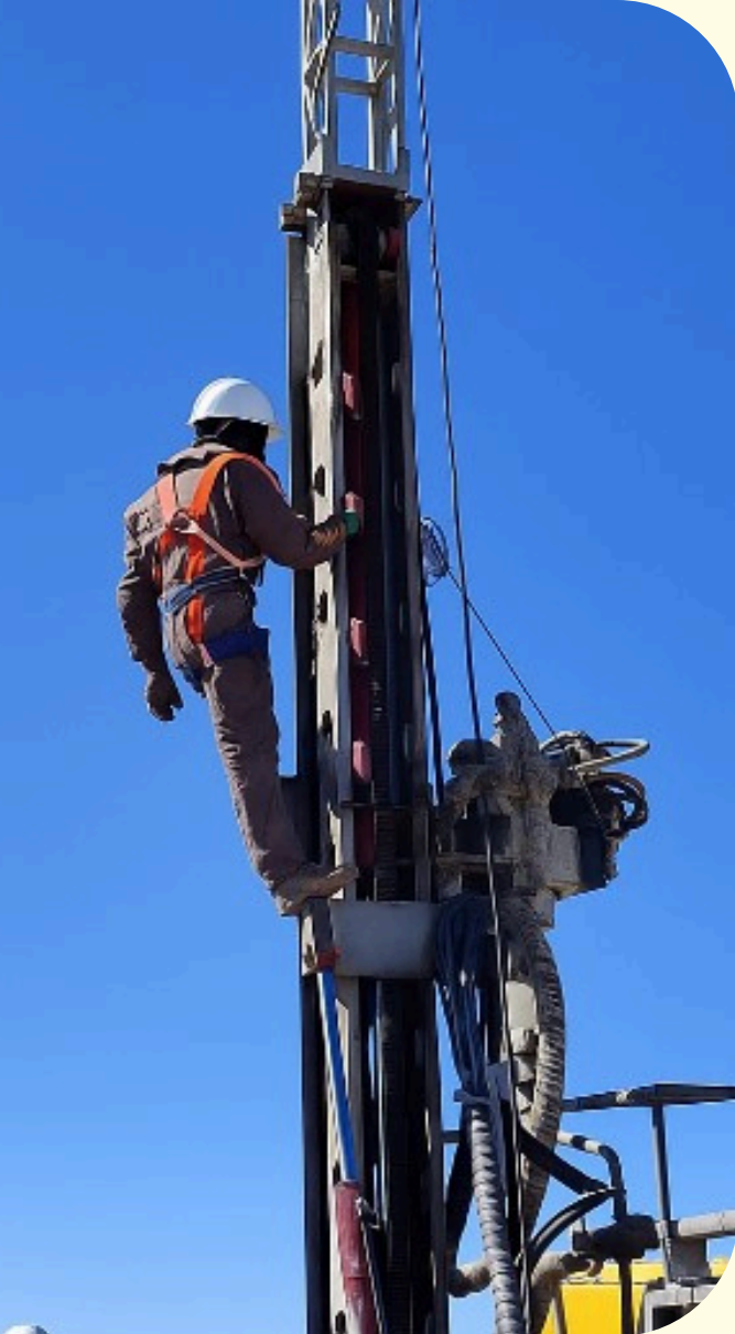
Personal con Equipo de Protección Personal (EPP) y uso adecuado de arnés en labores en altura
