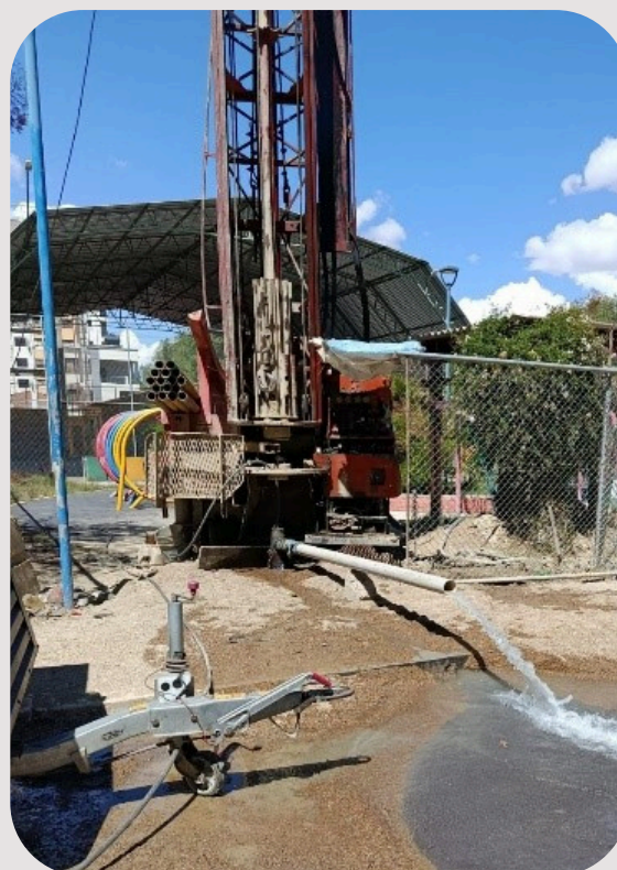
Desarrollo de pozo mediante Air Lift.
